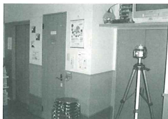
③建物内部のレベル測定状況
