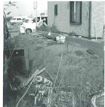
⑥抑え盛土状況
