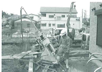
①注入状況
