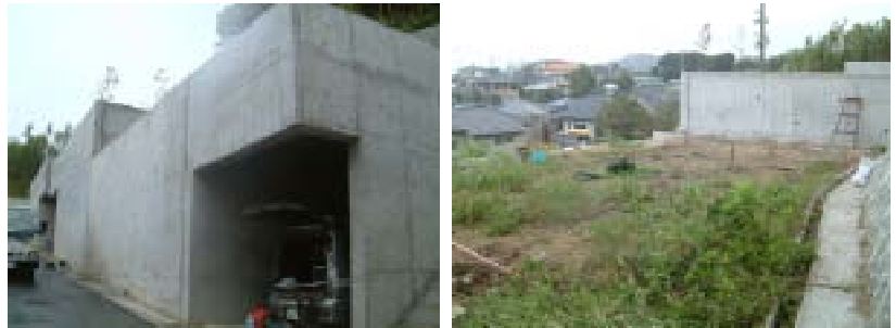
写真1 試験位置(左: 擁壁全景、右: 敷地全景)
